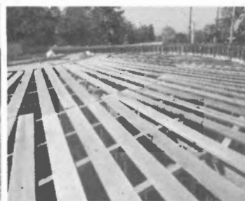
Inicio de trabajos de estructuras existentes para encofrado de la Cúpula de la Cisterna de 850 m 3
