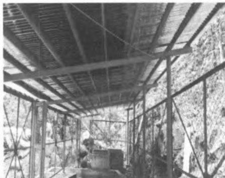
Cobertura metálica totalmente repuesta en Desarenador de Cachiyacu. Observaciones en acta de recepciones parciales
