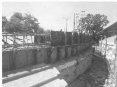
Inicio de trabajos de estructuras existentes para encofrado de la Cúpula de la Cisterna de 850 m 3
