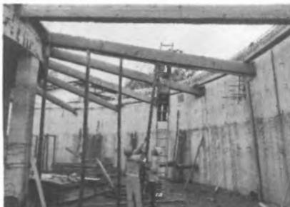
Inicio de trabajos de estructuras existentes para encofrado de la Cúpula de la Cisterna de 850 m 3
